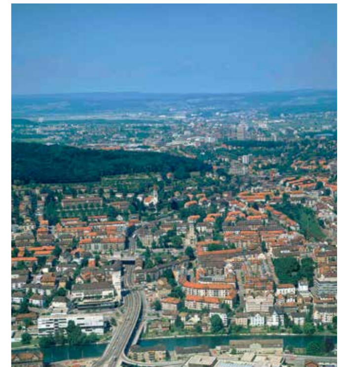
Die alte Bausünde in unserer blühenden Stadt soll endlich behoben werden.
