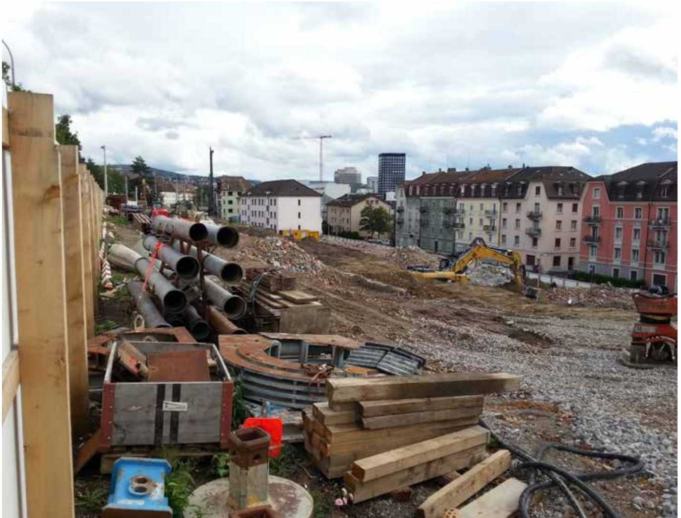
Und so sah es aus, als alle Häuser abgerissen waren.
