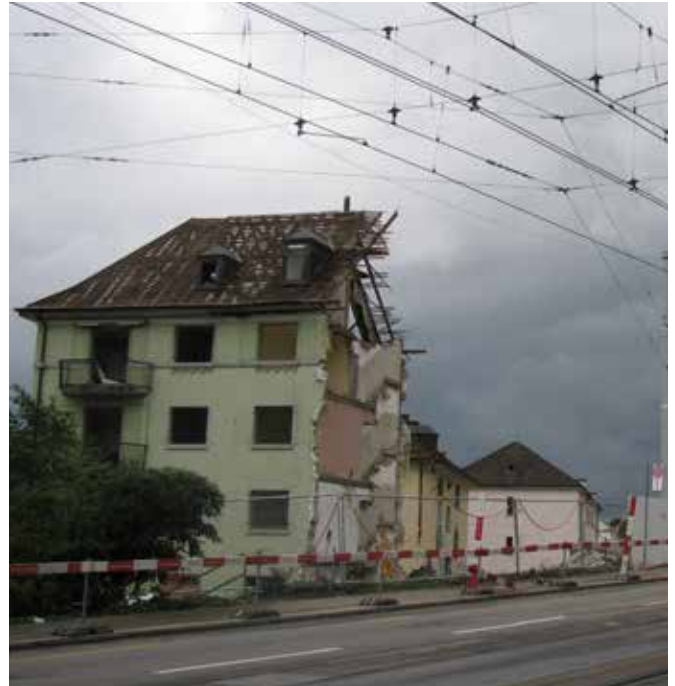
Fast gespenstischer Anblick der Genossenschaftssiedlung Sydefädeli bei der Halbzeit des Abriss.
