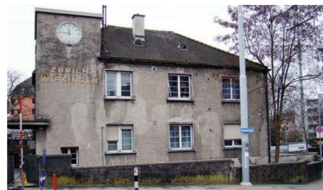
Bahnhof Wipkingen «vorher» und «nachher».
