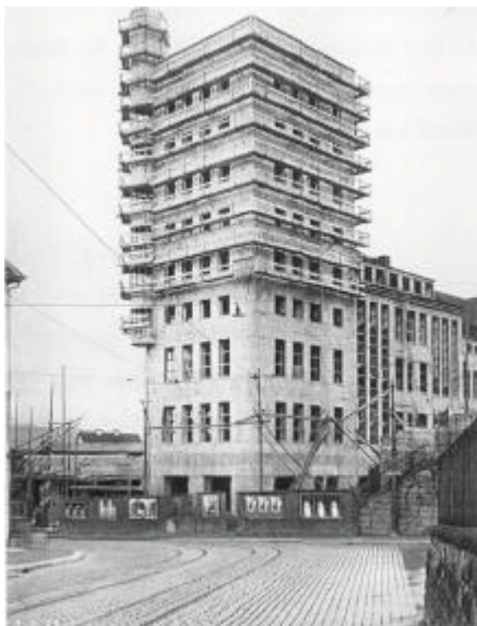
Das Kirchgemeindehaus im Bau, 1931. Der Turm wurde damals als Wolkenkratzer empfunden. Eigentliche Hochhäuser gab es in Zürich erst zwanzig Jahre später. (Bild: BAZ)
