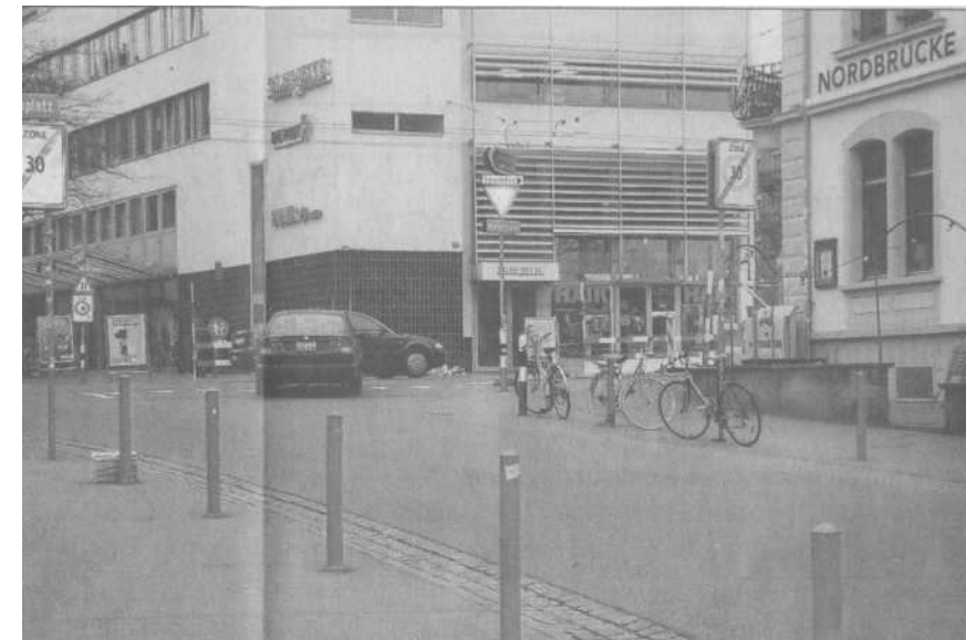
Bis Anfang 2014 gilt auf diesem Teilstück der Röschibachstrasse wegen der Bauarbeiten an der Nordbrücke Einbahnverkehr. Foto: pm.
