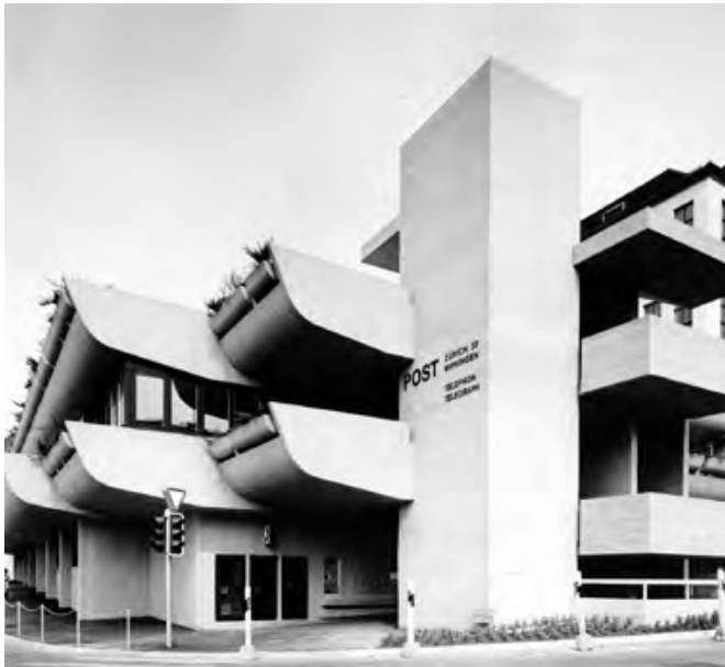
Das Postgebäude am Wipkingerplatz.
