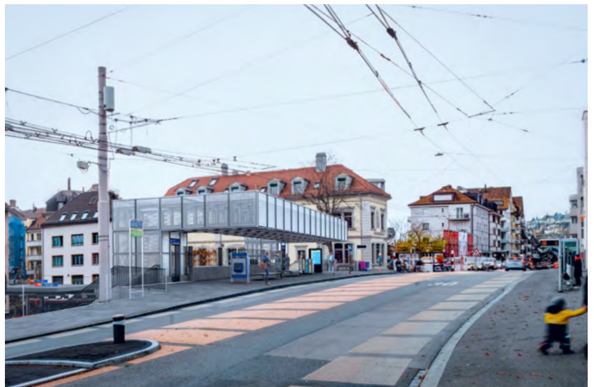
Blick auf die Frontseite der Bushaltestellen-Überdachung auf der Nordbrücke.
