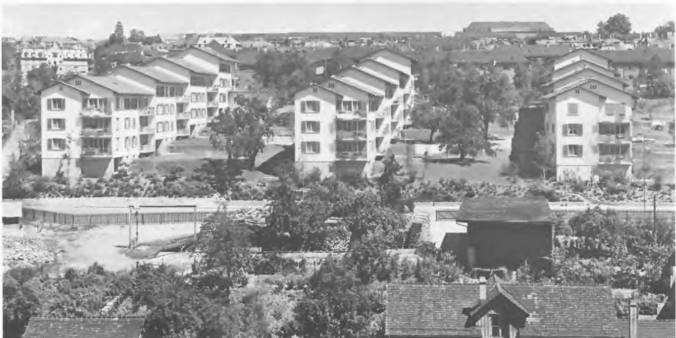
Bild 18 Ins Gesamtkonzept der Sanierung gehörte auch die Erstellung von Genossenschaftswohnungen. Unten das Gelände der heutigen Badeanstalt.
