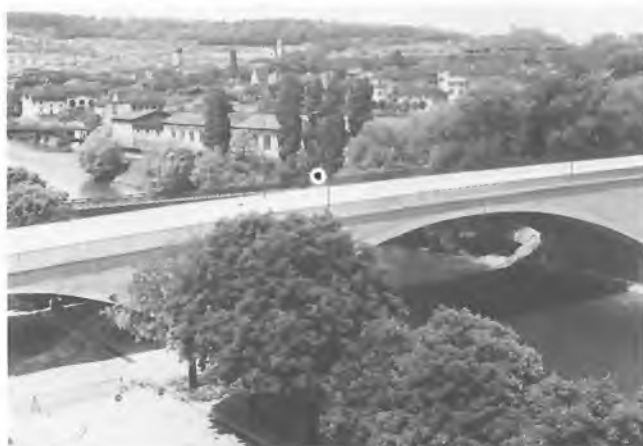
Bild 14 Hinter der 1930 neu erstellten Kornhausbrücke sind das Wasserwerk bereits wieder ohne Hochkammine, die Seidenwebschule und die 1908 erbaute Umformerstation zu sehen. Im Vordergrund wie im Hintergrund reiches Grün!
