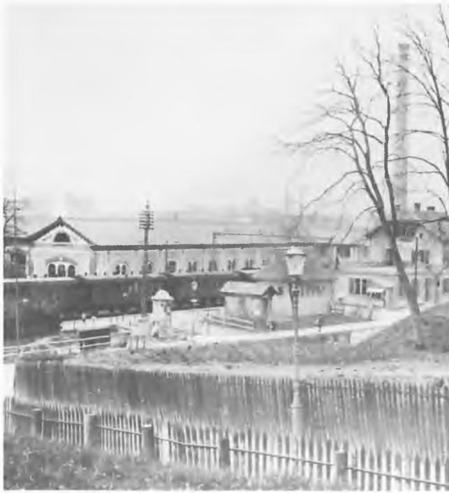
Bild 12 Pump- und Wasserwerk mit dem 1893 erbauten Bahnhof Letten.
