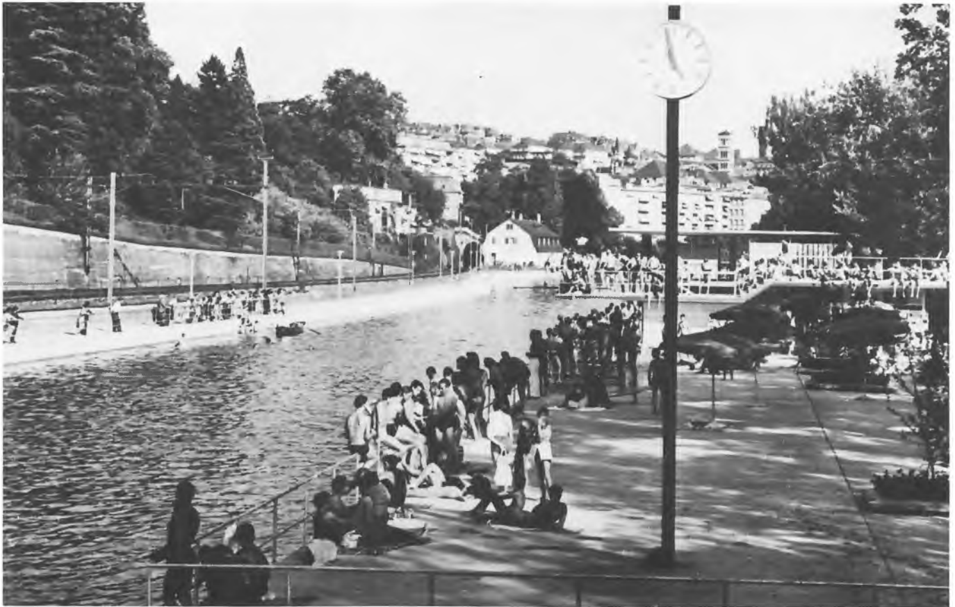
Bild 23 Badeanstalt Letten-Oberwasserkanal, erbaut 1952.
