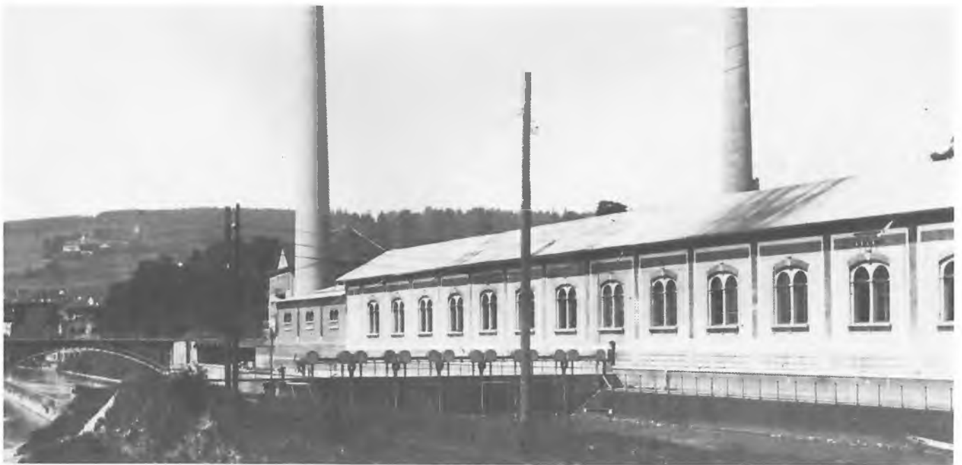
Bild 9 Photo des Pumpwerkes im Letten um 1900. Verschiedene technische Neuerungen haben das Aussehen der Anlage verändert: 1892 Installation von Dynamos zur Elektrizitäts-
