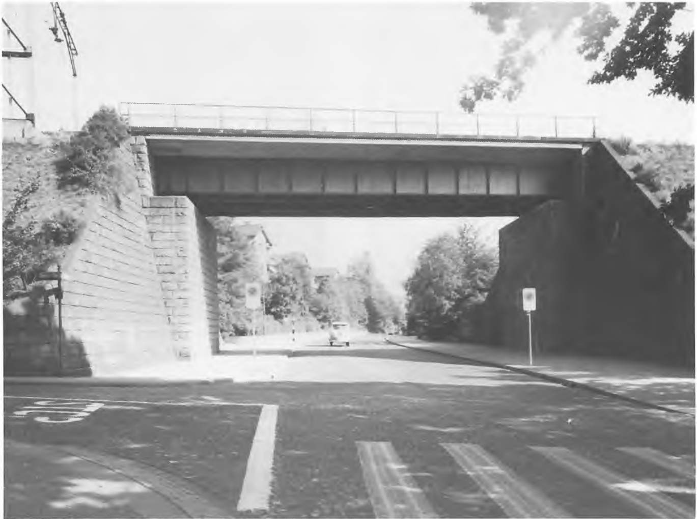
Bild 17 Freie Bahn dem Automobil! Durchstich des Bahndammes nach der «Sanierung».
