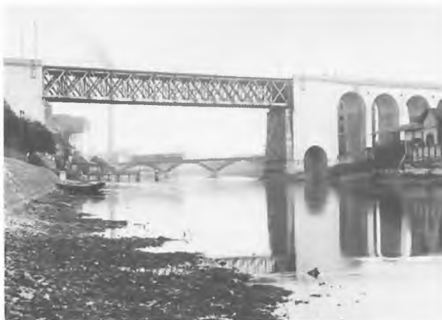
Bild 13 Die beiden Limmatbrücken im Jahre 1925.
