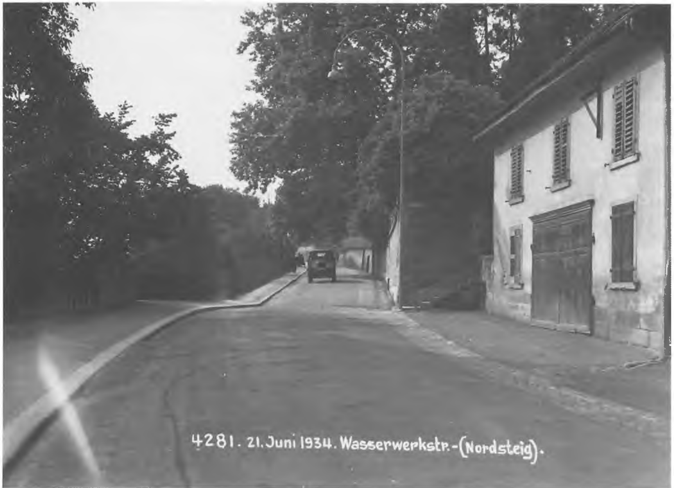
Bild 19 Alte Wasserwerkstrasse auf der Höhe des Drahtschmidlis.
