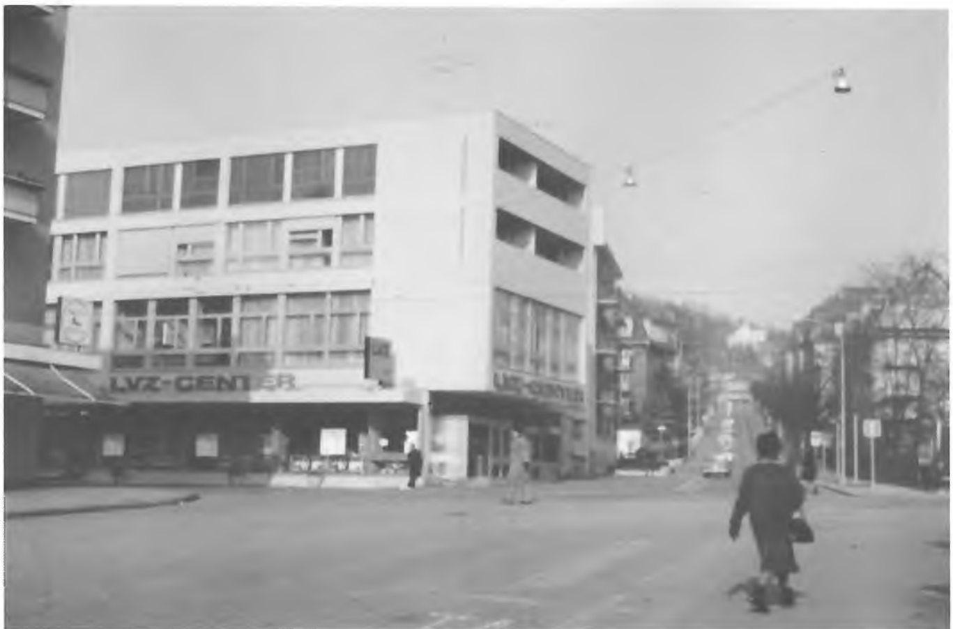
Blick auf Nordstrasse/Ecke Scheffelstrasse heute. Städtebaulicher Sündenfall der 60er Jahre und Vorgeschmack auf die Zuriegelung, welche eine sechs-
