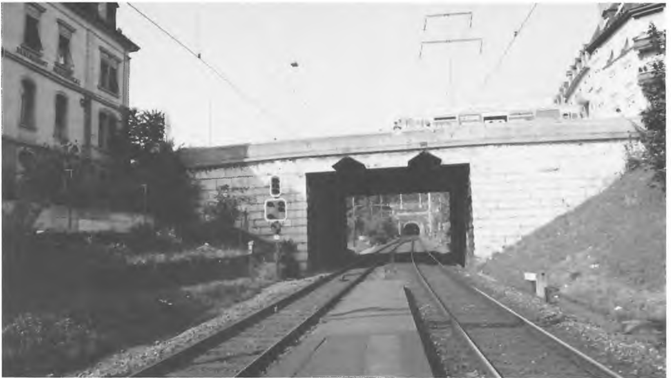
Die formschöne Nordbrücke und das Tunnelportal, wie sie sich 1985 präsentieren.
