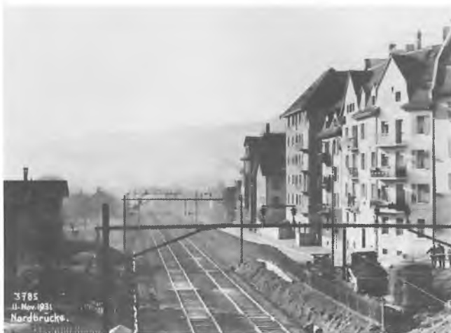
Blick von der Nordbrücke Richtung Uetliberg. Links wiederum die Blockwärterhäuschen, rechts die Aushubarbeiten für den Bahnhof Wipkingen (Eröffnung 1932) in vollem Gang.
