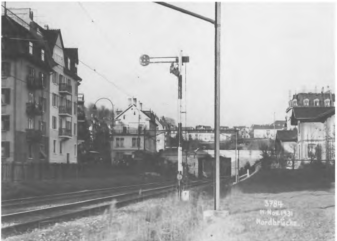
Die Photo aus dem Jahre 1931 zeigt den Zusammenhang der Eisenbahnbauten in Wipkingen: Der Bahndamm mündet in den Bahneinschnitt über. 1890 wurde die Nordbrücke erbaut, damit wurde der Eisenbahneinschnitt leicht passierbar. Rechts auf dem Bild die 1908/09 erbauten Blockwärterhäuschen. Unterhalb des gut proportionierten Restaurants Nordbrücke wird 1931 mit den Aushubarbeiten für den Bahnhof Wipkingen begonnen. Zu beachten sind das offene Semaphor Richtung Oerlikon und das geschlossene Semaphor Richtung Zürich HB.
