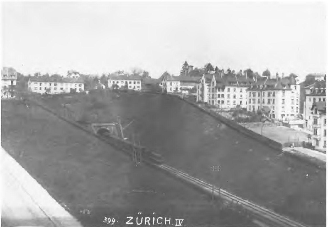
Einschnitt mit Tunnel um 1910. Mehr als 50 Jahre nach dem Bau der Bahnlinie ist erst die Seite «Rötelsteig» mit einer auf den Einschnitt gerichteten Randbebauung versehen. Noch heute stellt der Rötelsteig
