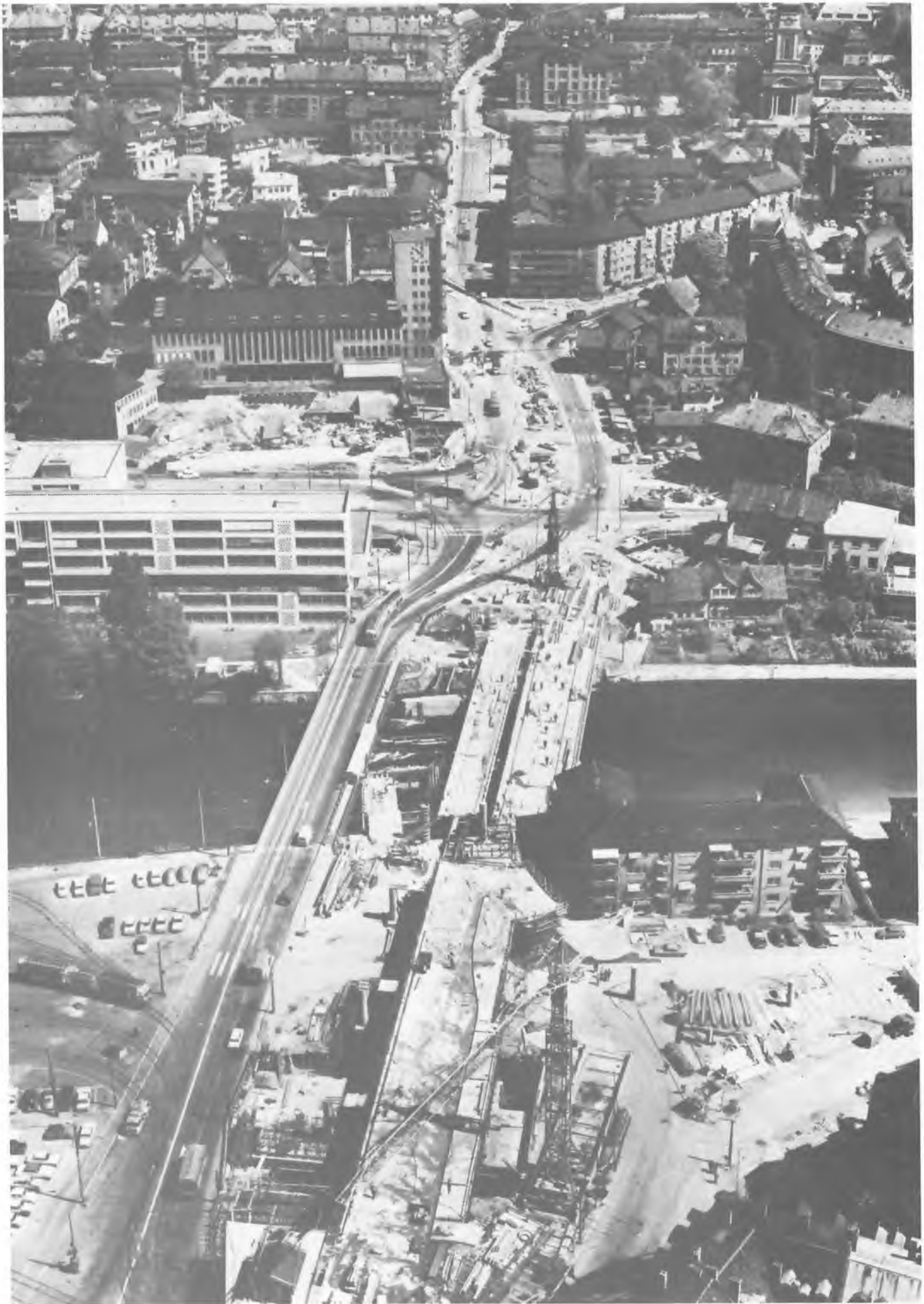
8. Wipkingenbrücke im Bau, Mai 1969
