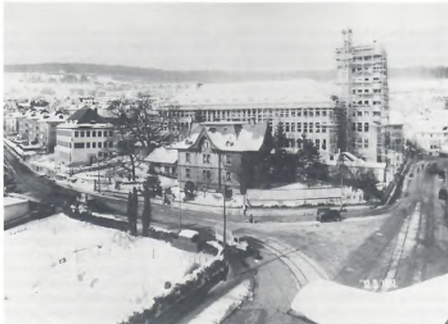
Kirchgemeindehaus Wipkingen im Bau, mit alter und neuer Kinderkrippe.
