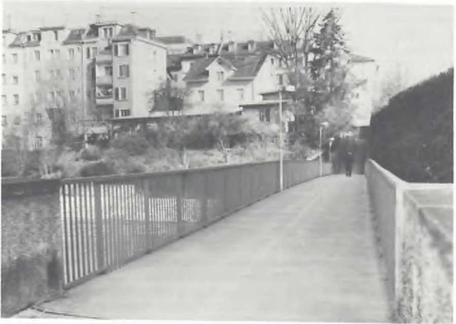
Dammsteg, 1926 erstellt, gegen Höngerstrasse.
