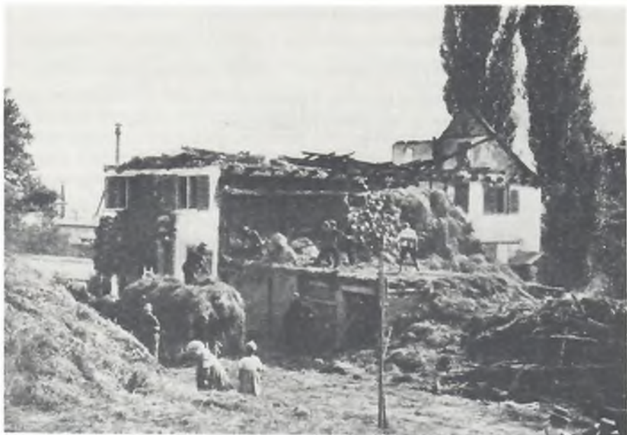
Rötelstasse 81 nach dem Brand vom 11. August 1904.
