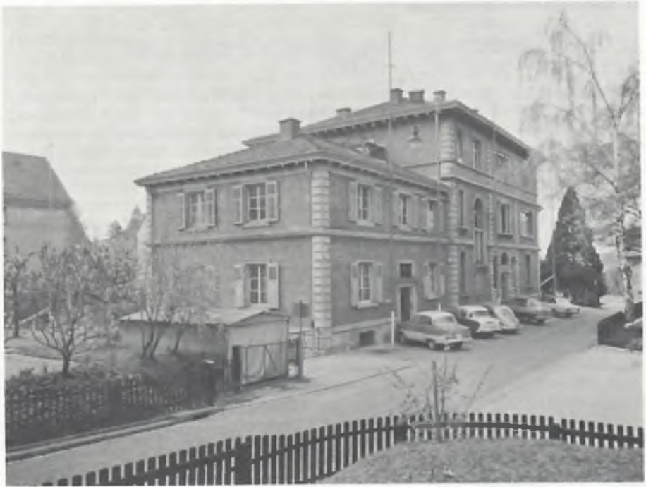
Okenstrasse 4/6, abgebrochen 1967, erbaut 1877 von Hch. Mousson-von May in einen alten Landsitz hinein, dessen Reiz der grossartige Baumbestand ausmachte. Die AG Ed. Züblin+Co. baut hier für eigene Zwecke. (Baugeschichtliches Archiv)
