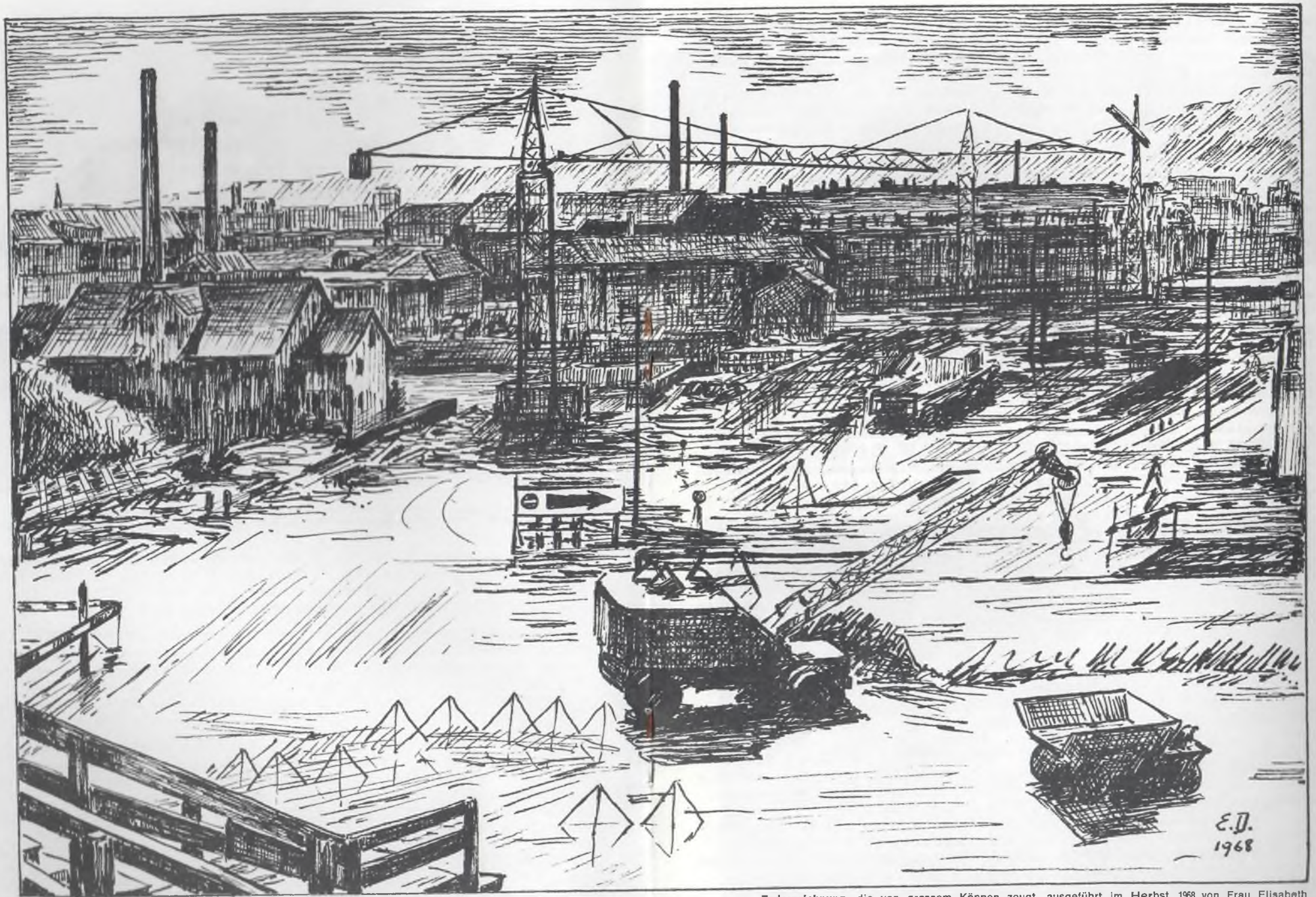
Federzeichnung, die von grossem Können zeugt, ausgeführt im Herbst 1968 von Frau Elisabeth Diggelmann, Höneggerstr. 75, den damaligen Stand der Bauarbeiten an der Doppelbrücke zeigend.
