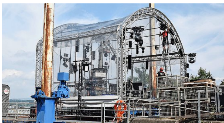
Auf einem zwölf mal zwölf Meter grossen Floss wird die neun mal sechs Meter grosse Bühne aufgebaut. Foto: Irene Lustenberger
