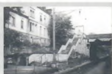
TREPPENABGANG VON DER NORDBRÜCKE ZUM BAHNHOFVORPLATZ DES BAHNHOFES WIPKINGEN
