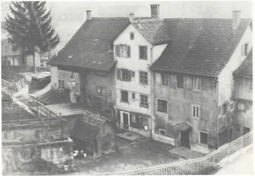
Röschibachstrasse 4a – 10, Photo: O. Baur
