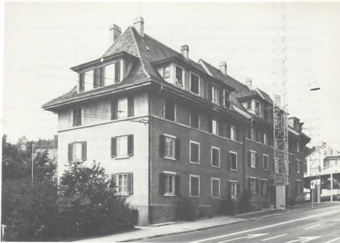
Aus dem Wipkinger Abreiss-Kalender 1977 Bucheggstrasse 54 und Rötelstrasse 125/127, erbaut 1925. (Das vorerst geplante Hochhaus wurde nicht bewilligt).
