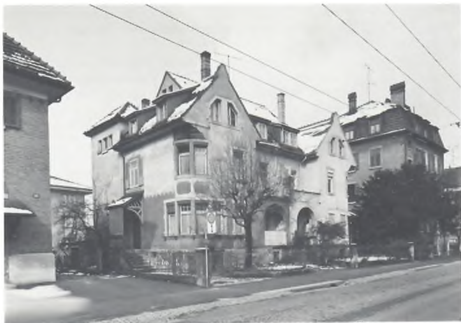
Rötelstrasse 67, 69, 71 (Schucht Foto)
