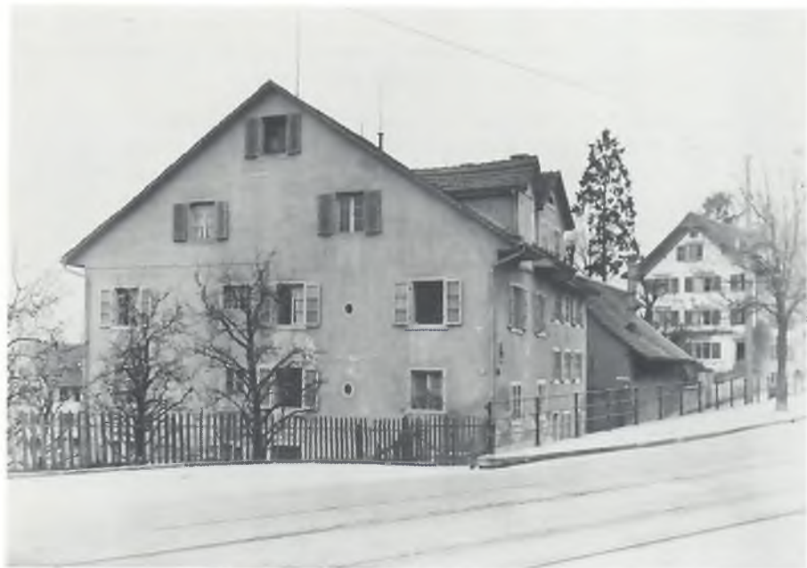
Hönggerstrasse 119/121, Nordseite, 1946. (Baugeschichtliches Archiv)
