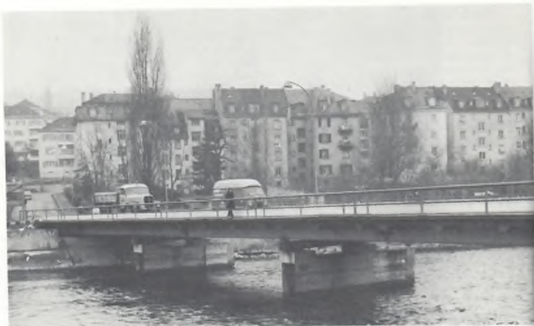
Hilfsbrücke über die Limmat, von der Ampère- gegen die Hardturmstrasse hin, wird im Sommer 1970 abmontiert und provisorisch bei der Hochbrücke als Auffahrtsrampe verwendet. (Aufnahme: O. Baur)
