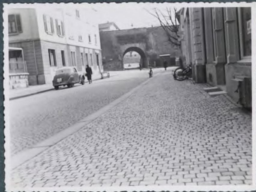
Tunnel an der Dammstrasse
