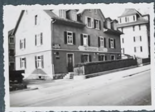
Rest. Rötel, Rötelstrasse 121.
