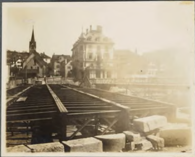
Neue Brücke im Bau
