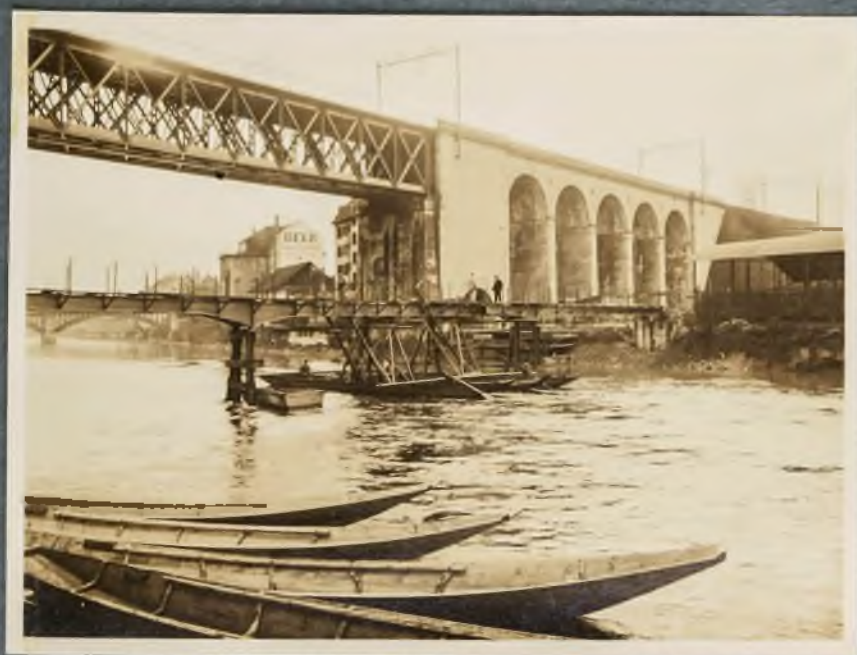
Dammsteg im Bau
