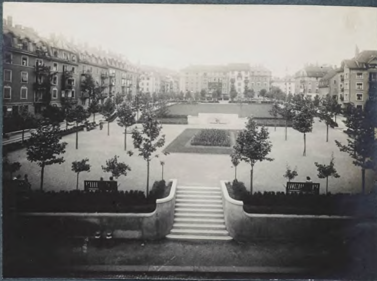
Neue Anlage Habsburgstrasse
