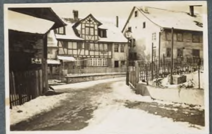
Altes Schul- und Gemeindehaus 1665
