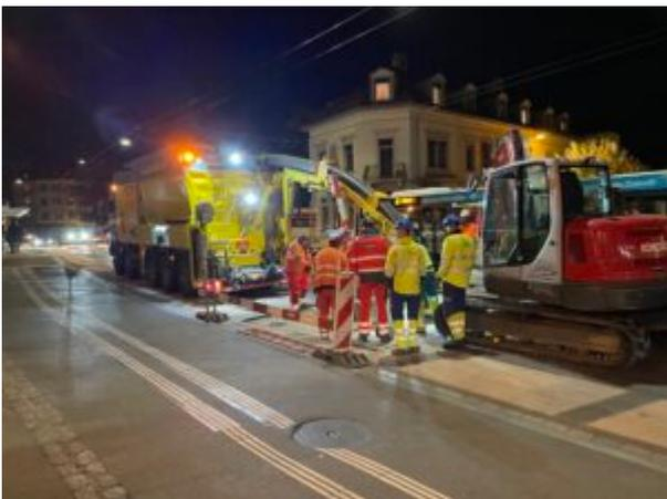
Die Wasserleitungen werden ausgetauscht, die Baugruben zugefüllt und ein neuer Deckbelag eingebracht, so dass die Strassenräume wieder uneingeschränkt wieder zur Verfügung stehen.
