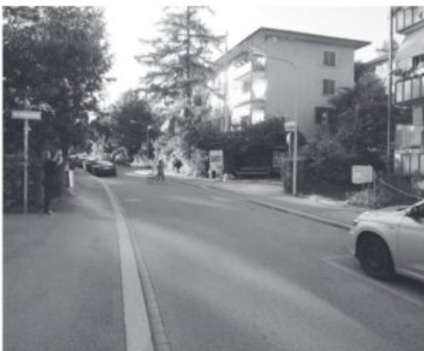
Der Strassenraum heute.
