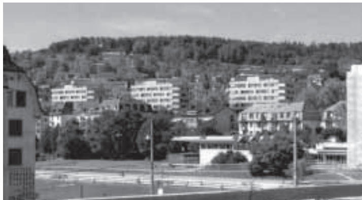
Triangoli-Projekt an der Breitensteinstrassè (Fotomontage der Baugenossenschaft Denzler), Ansicht vom Escher Wyss Platz.
