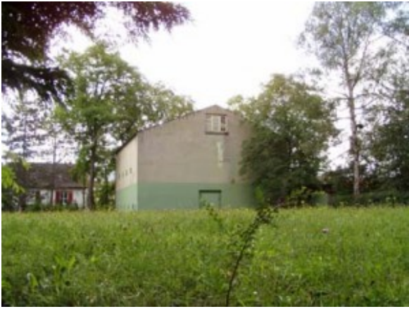
Das Gebäude des Wasserwerkes
